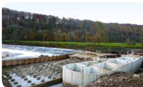
▷ Construction d'une passe à poissons au pied de la retenue d'eau
