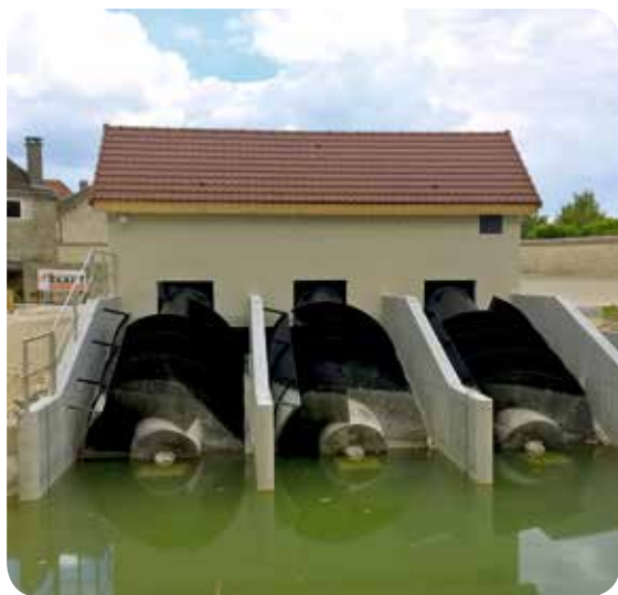
▷ Les vis hydrodynamiques n'entravent pas la circulation descendante des poissons dans la rivière (vis ichtyocompatible)
