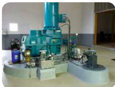
▷ Multiplicateur de vitesse et génératrice de courant
