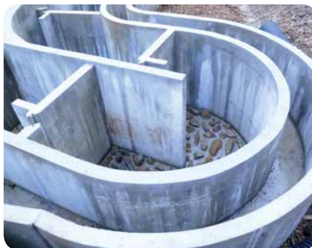
▷ 240 400 € HT investis pour implanter une passe à poissons pour une hauteur de chute nette de 2,1 m - Centrale de Briennon-sur-Armançon (89)
