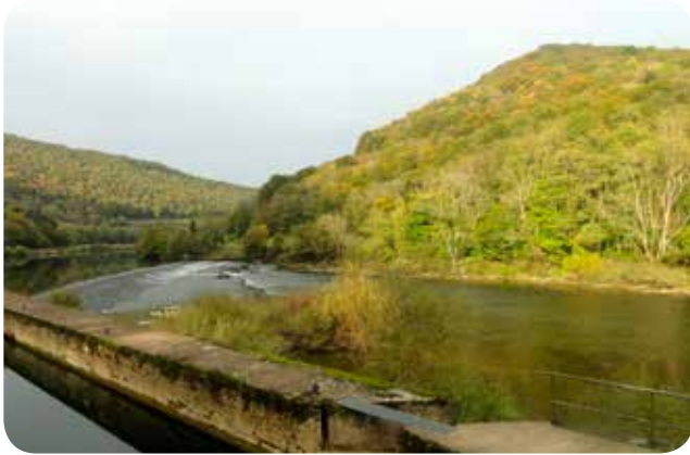
▷ Retenue d'eau d'une centrale - Laissey (25)
