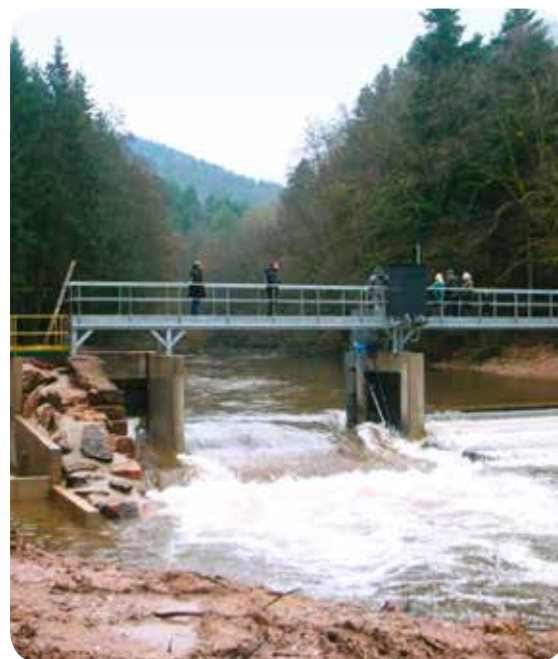
▷ Centrale de Raon-l'Étape (88) rénovée grâce à son acquisition par Ercisol
