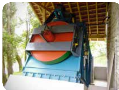
▷ Tête de la turbine Kaplan inclinée en siphon
