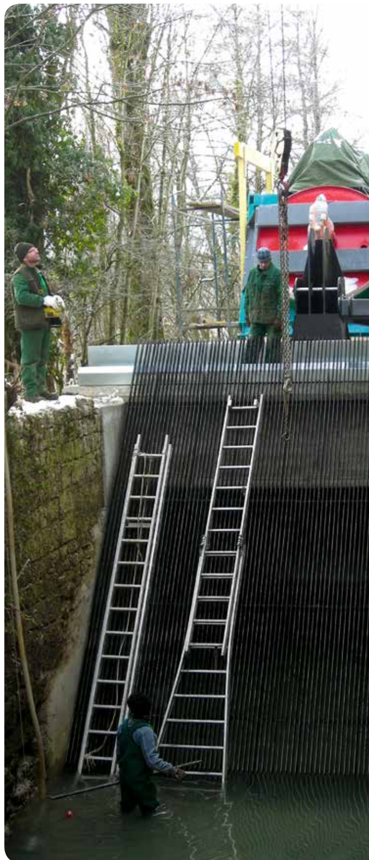
▷ Mise en place de la grille de prise d'eau - Moulin Billerey - Arc-et-Senans (25)
