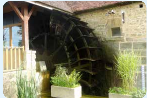
▷ Roue à aubes de type Zuppinger entièrement fabriquée par les membres de l'association
