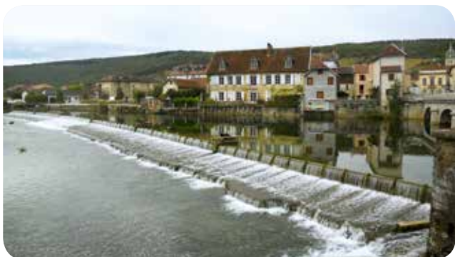
▷ Barrage sur la Loue - Quingey (25)
