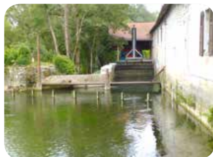
▷ Prise d'eau avec le dégrilleur
