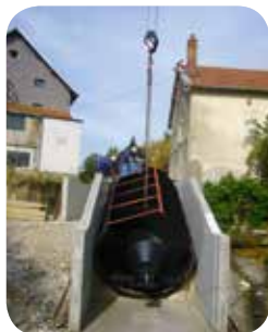
▷ Installation de la vis hydrodynamique
