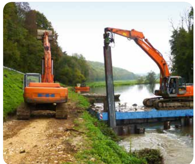
▷ Intervention sur barge pour création d'un atardeau en palplanches - Centrale de Ray-sur-Saône (70)
