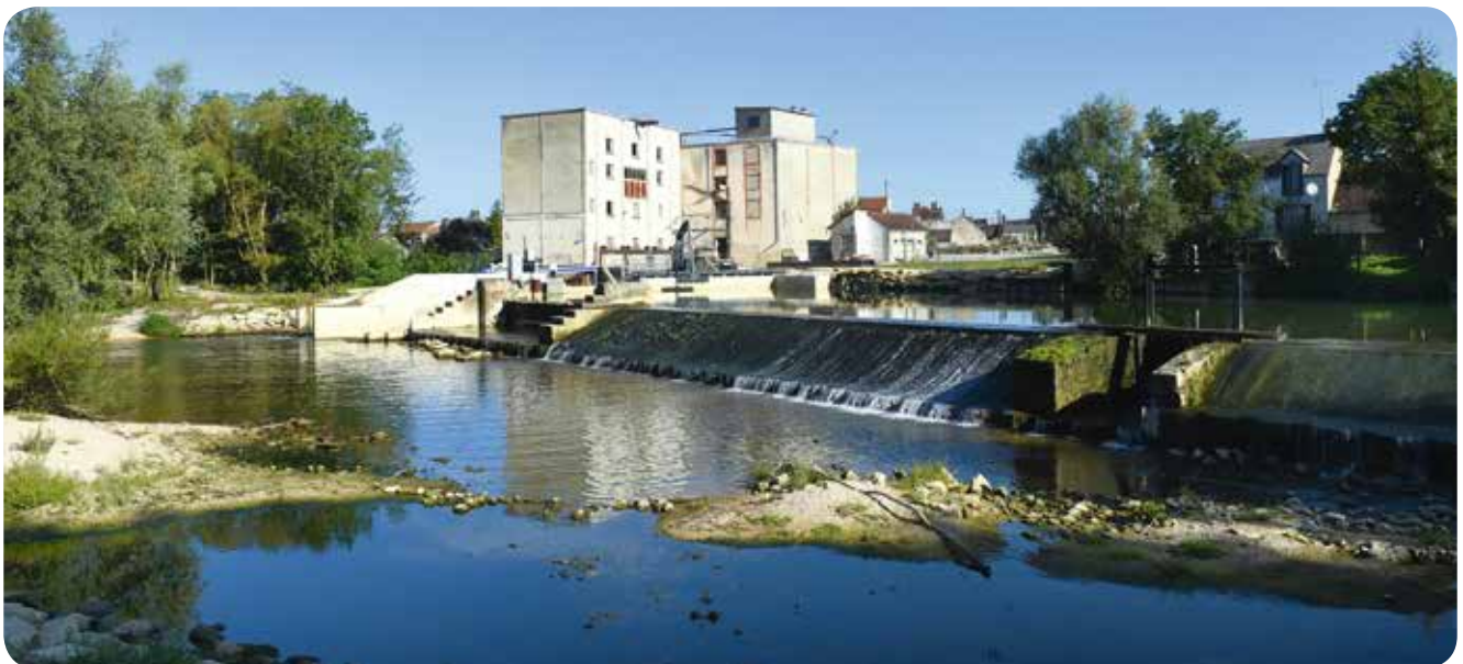
▷ Après travaux d'optimisation, la centrale du moulin de la Tête Noire a amélioré sa production de 50 % - Briennon-sur-Armançon (89)
