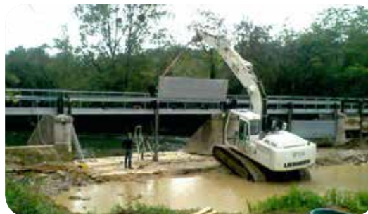
▷ Travaux de rénovation et d'automatisation du vannage
