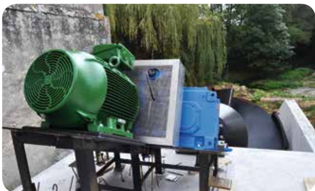
▷ Vis hydrodynamique - Champdôtre (21) • générateur en vert et multiplicateur en bleu (centrale en cours de construction)
