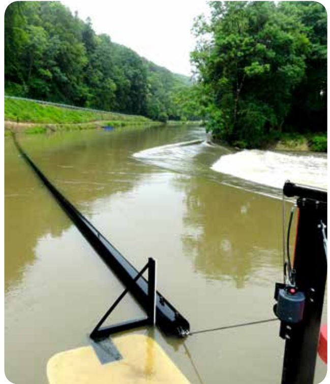
➤ Drome (avec système de contrepoids) pour détourner les objets flottants - Centrale de Ray-sur-Saône (70)
