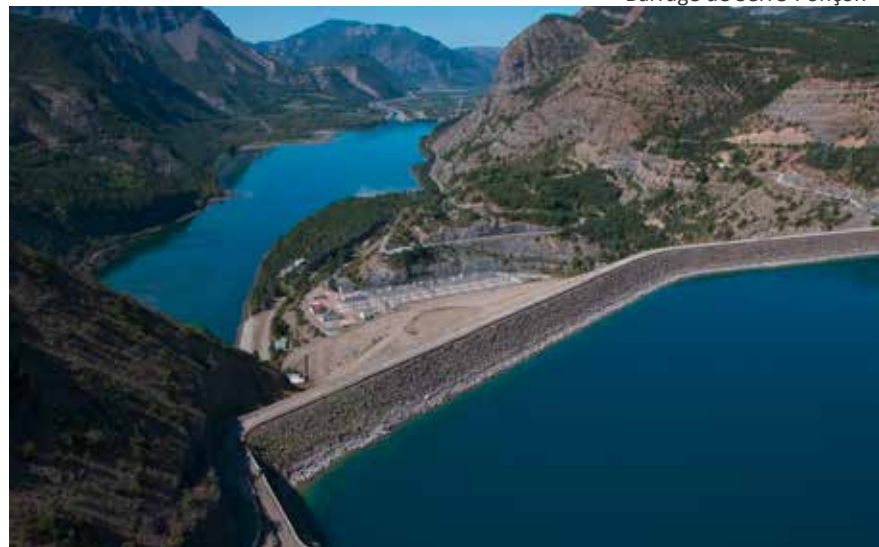
Barrage de Serre-Ponçon
