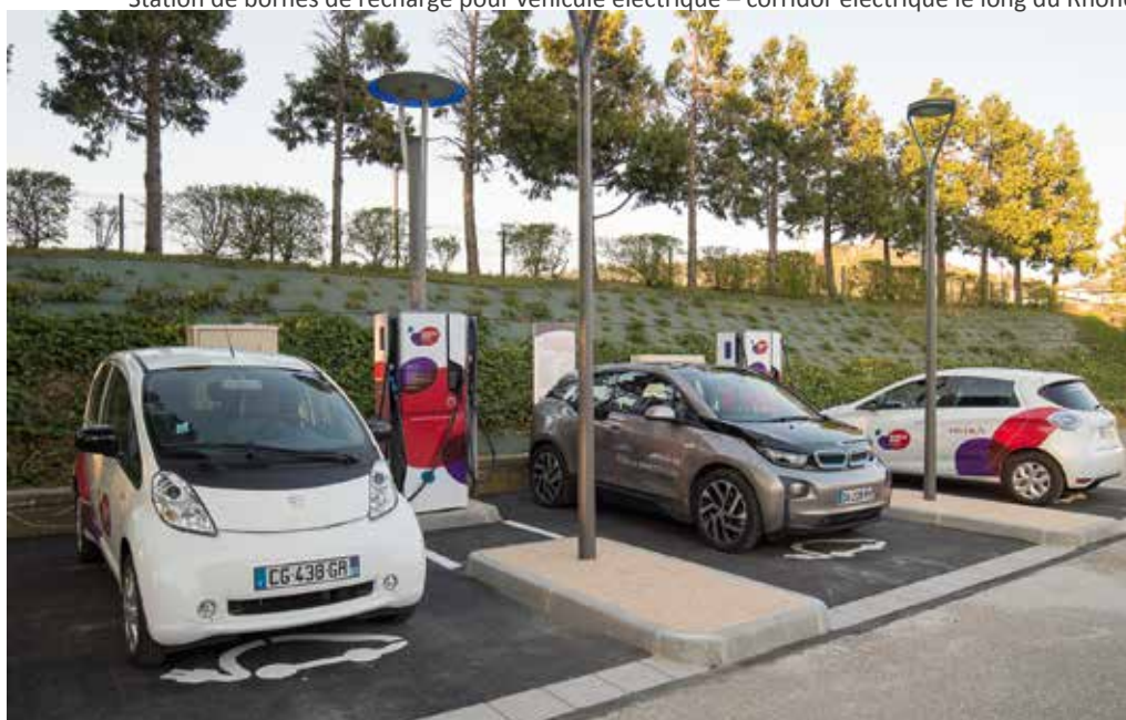
Station de bornes de recharge pour véhicule électrique – corridor électrique le long du Rhône
