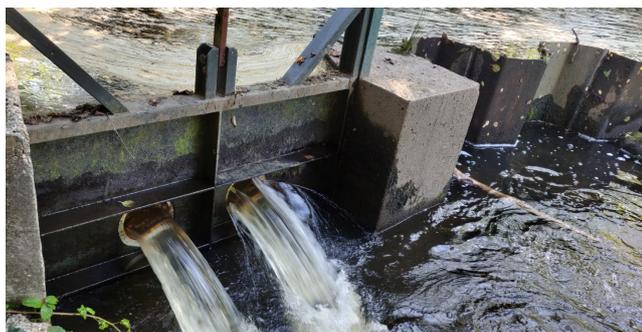
Orifices calibrés réalisés dans une vanne pour l'écoulement du débit réservé.
