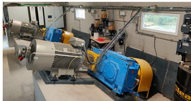
La centrale de Roffey (89) dispose de deux vis hydrodynamiques qui entraînent chacune un multiplicateur à engrenages (en bleu) couplé à une génératrice asynchrone (en gris)
