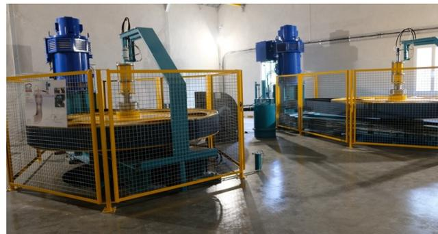
Turbines Kaplan équipées de multiplicateurs par poulie-courroie et de génératrices synchrones - Centrale d'Emagny (25)
