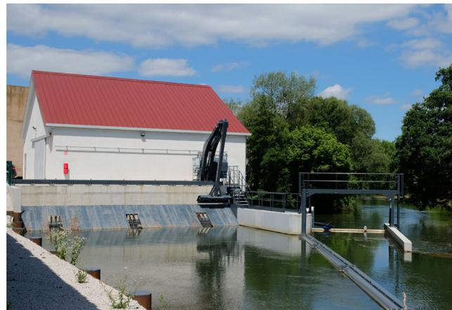
Prise d'eau équipée d'un dégrilleur mobile à bras - Centrale d'Emagny (25)
