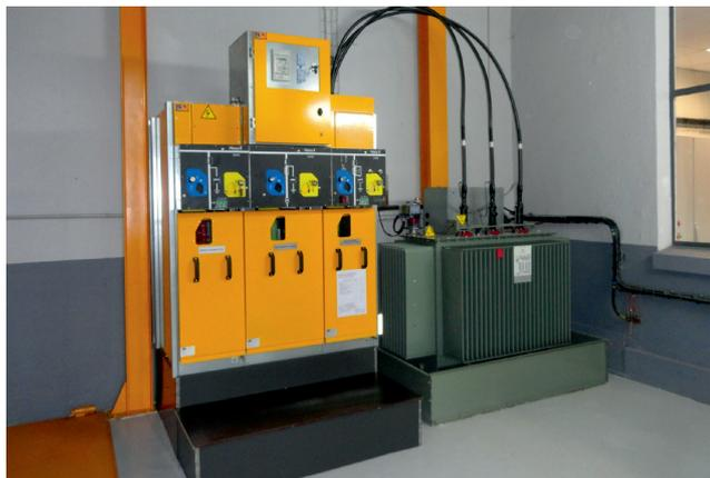
Cellules HTA (à gauche) et transformateur (à droite) - Centrale de Ray-sur-Saône (70)
