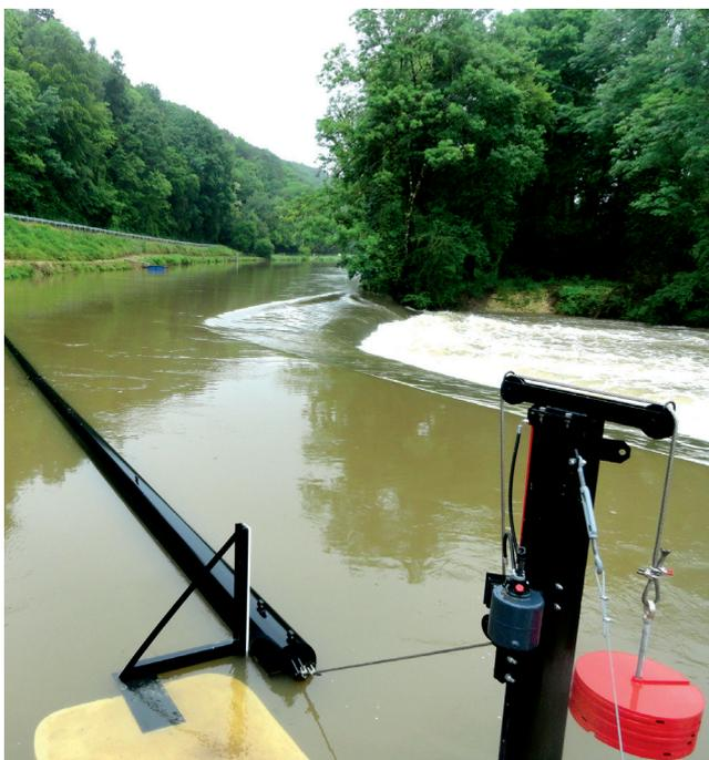
Drome (avec système de contrepois) pour détourner les objets flottants - Centrale de Ray-sur-Saône (70)
