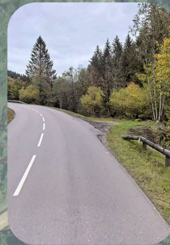
Accès prise d'eau : 48.035591 , 6.850975
